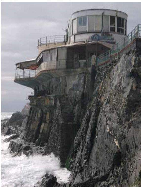
Fig. 16. Nervi. La Marinella, veduta generale del complesso da sud-est
