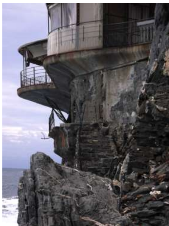
Fig. 15. Nervi. La Marinella, veduta da sud-est della parete rocciosa e delle aggiunte successive
