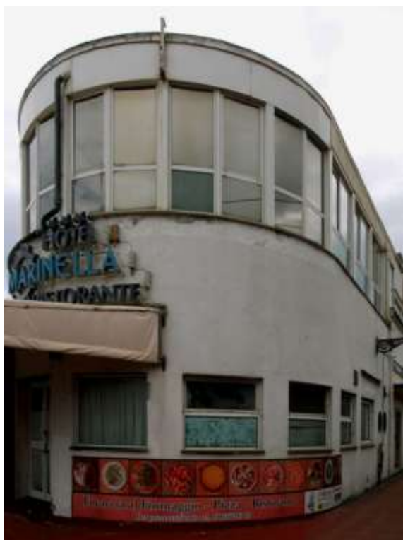
Fig. 17. Nervi. La Marinella, veduta attuale della costruzione da est
